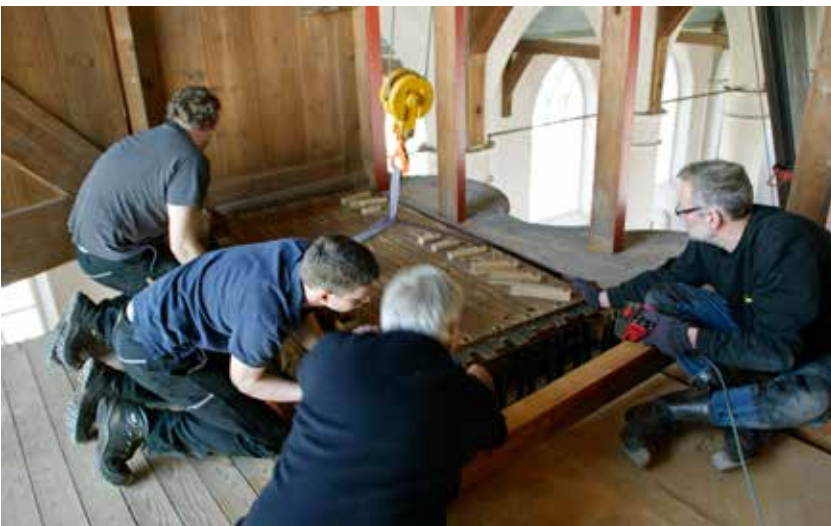
De hoofdwerkklade wordt op zijn plaats gelegd.
